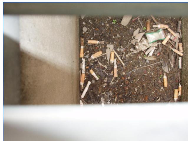
写真3 側溝への吸い殻ポイ捨て状況(平成18年4月)
